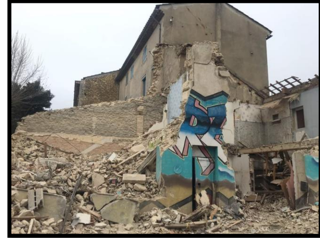
Déconstruction ancienne conciergerie
