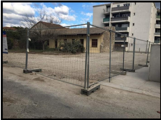
Déconstruction des cuisines Benoît
